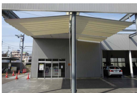
作業スペースをより快適に
