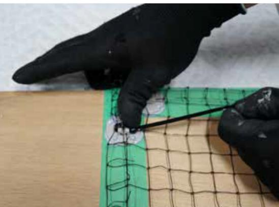
⑪必ず専用取付具を抑えながら結束バンドを締めます。
