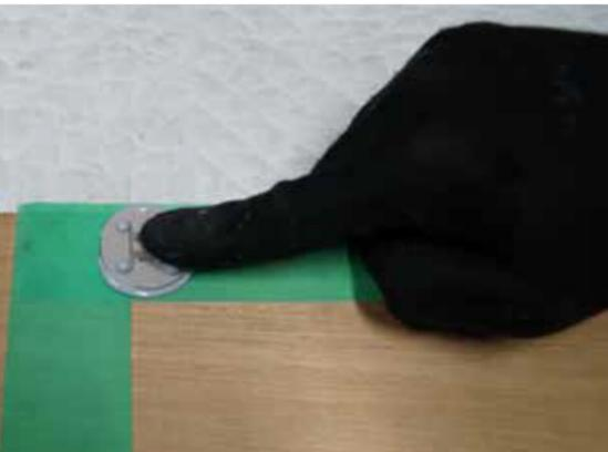
①専用取付具を30cm間隔（15mm 升目の場合は15cm間隔）で設置します。
